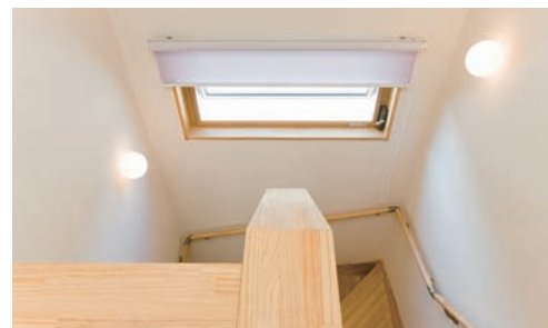
階段の踊り場にも横長の窓を設けた。北側から涼やかな風 が入り込む。
